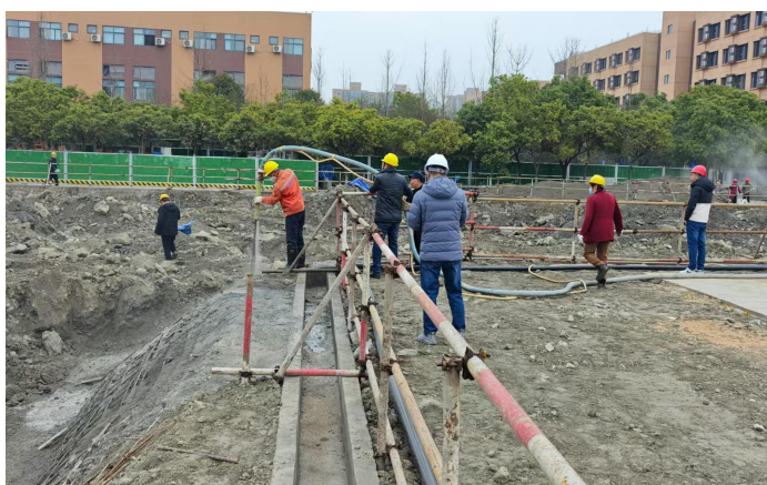
项目区基坑截水沟 (2025.2)
