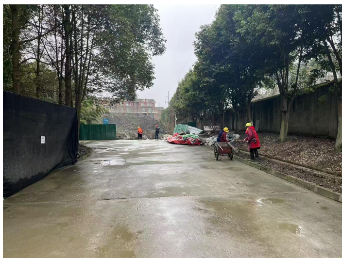
图4 项目区施工入口 (2025.1)
